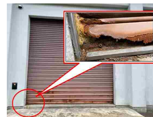
浄水場シャッター更新 (新玉川地区整備基盤施設)
