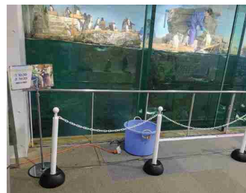
ペンギン水槽改修 (男鹿水族館)
